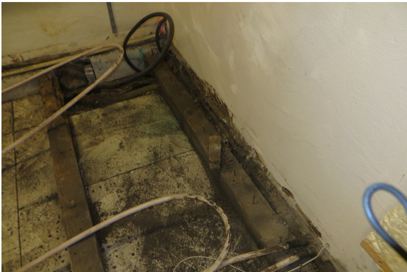
4. Majavammiga kahjustunud piirkond käärkambris (arhiivis) katuse neelukoha all
